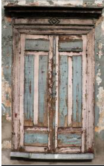
Ēka Lauku ielā Nr. 1, celta 1897.gadā, tehniķis Heinrihs Devendruss. Logu aile. 2012. gads.
