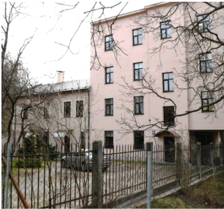
Ēkas Lauku ielā Nr. 12, koka divstāvu celta 1898.gadā, arhitekts Alfrēds Ašenkampfs un četrstāvu mūra celts 1929. gadā, tehniķis Indriķis Devendruss. 2012. gads.
